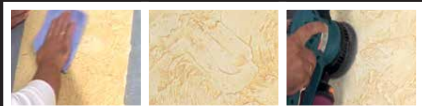
через три минуты после нанесения, поверхность протереть влажной тряпкой, что бы получить оттенок натурального камня
