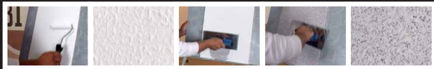
поверхность предварительно загрунтовать грунтовкой “Бетонконтакт”
