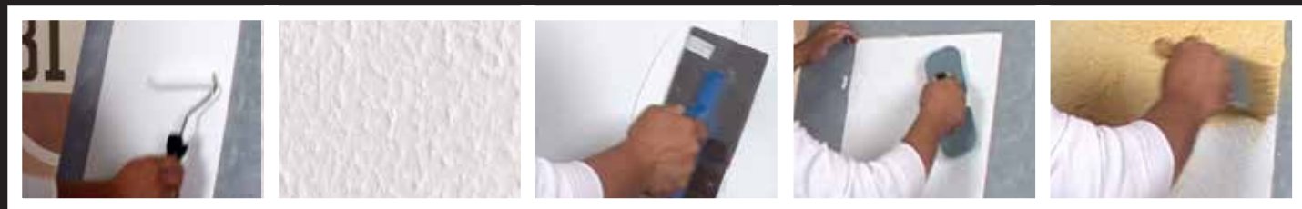
поверхность предварительно загрунтовать грунтовкой "Адгезионной"
