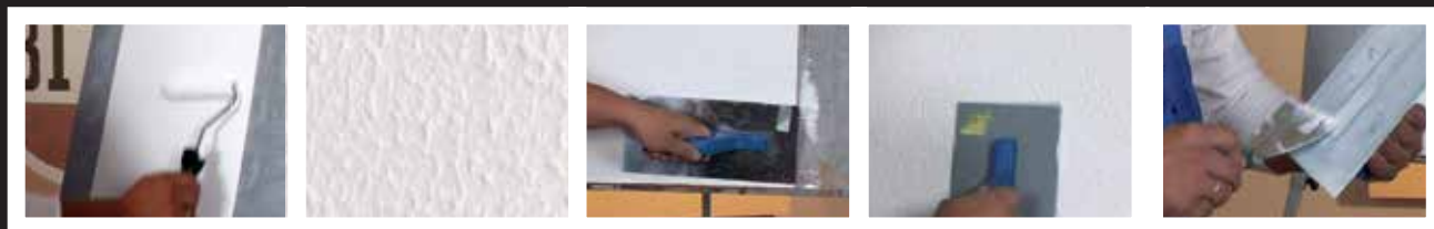
поверхность предварительно загрунтовать грунтовкой “Адгезионной”
